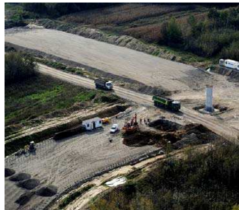
Vazdušni snimak radova na Koridoru Vc (2015)
